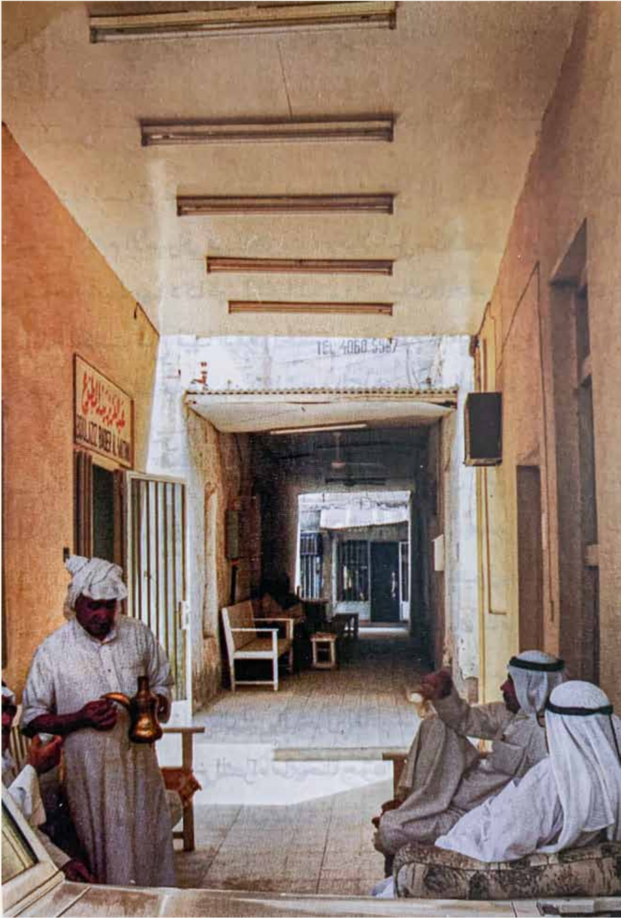
• صورة رقم (١): جانب من قيصرية البدر قبل هدمها وتجديدها (المصدر: محمد عبدالهادي جمال، أسواق الكويت القديمة، ص. ١٧٦).
